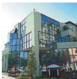
Управление на отоплението и вентилацията в сгради
